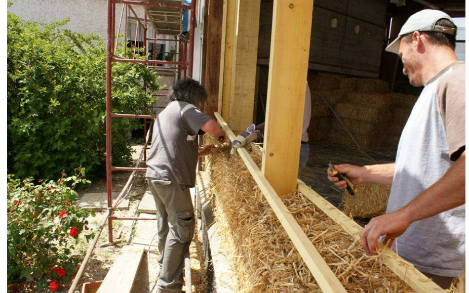
Le remplissage de l'ossature avec les bottes de paille © site Internet de la mairie de Chaumes-en-Brie (77)
